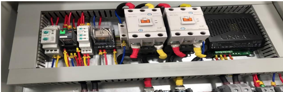
شكل (٣-١) يبين لوحة التبديل (لوحة الـ ATS)
